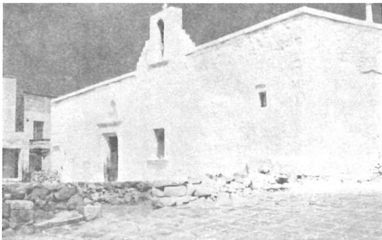
Εἰκ. 40. Ἡ Ν.Α. ἀποψις τοῦ ναοῦ τῆς Μεταμορφώσεως (Σωτήρας).
